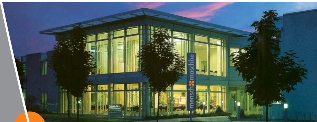
Die MuM-Firmenzentrale in Wessling bei München
